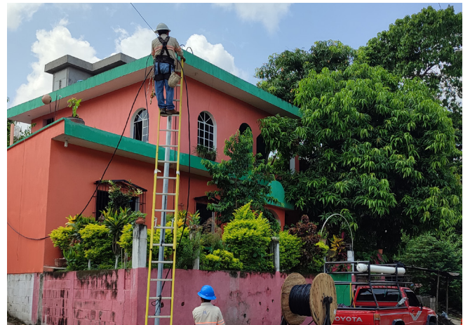
Introducción de energía eléctrica Cantón Xulá, Retalhuleu, Retalhuleu
