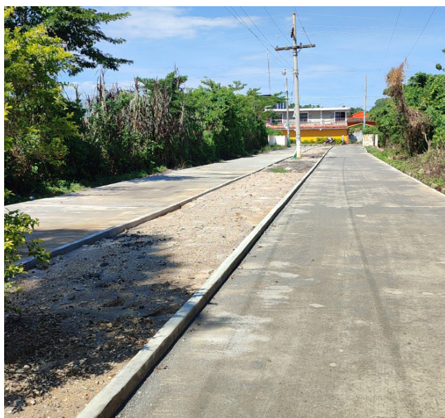
Mejoramiento calle ingreso a lotificación Ciudad Modelo, Retalhuleu, Retalhuleu.
