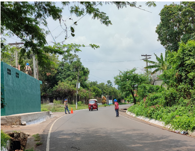
Introducción de energía eléctrica Vista Hermosa, Retalhuleu, Retalhuleu
