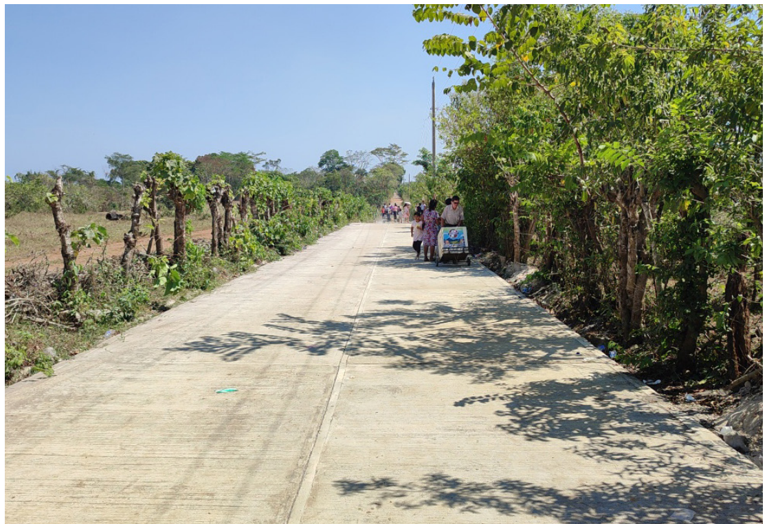
Mejoramiento camino rural, Aldea Las Pilas sector I, Retalhuleu, Retalhuleu
