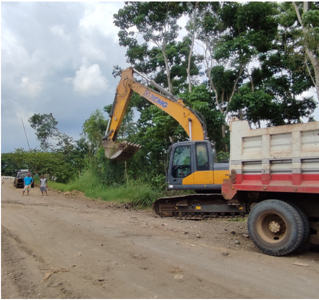
Mejoramiento camino rural Sector La Montaña, Retalhuleu, Retalhuleu
