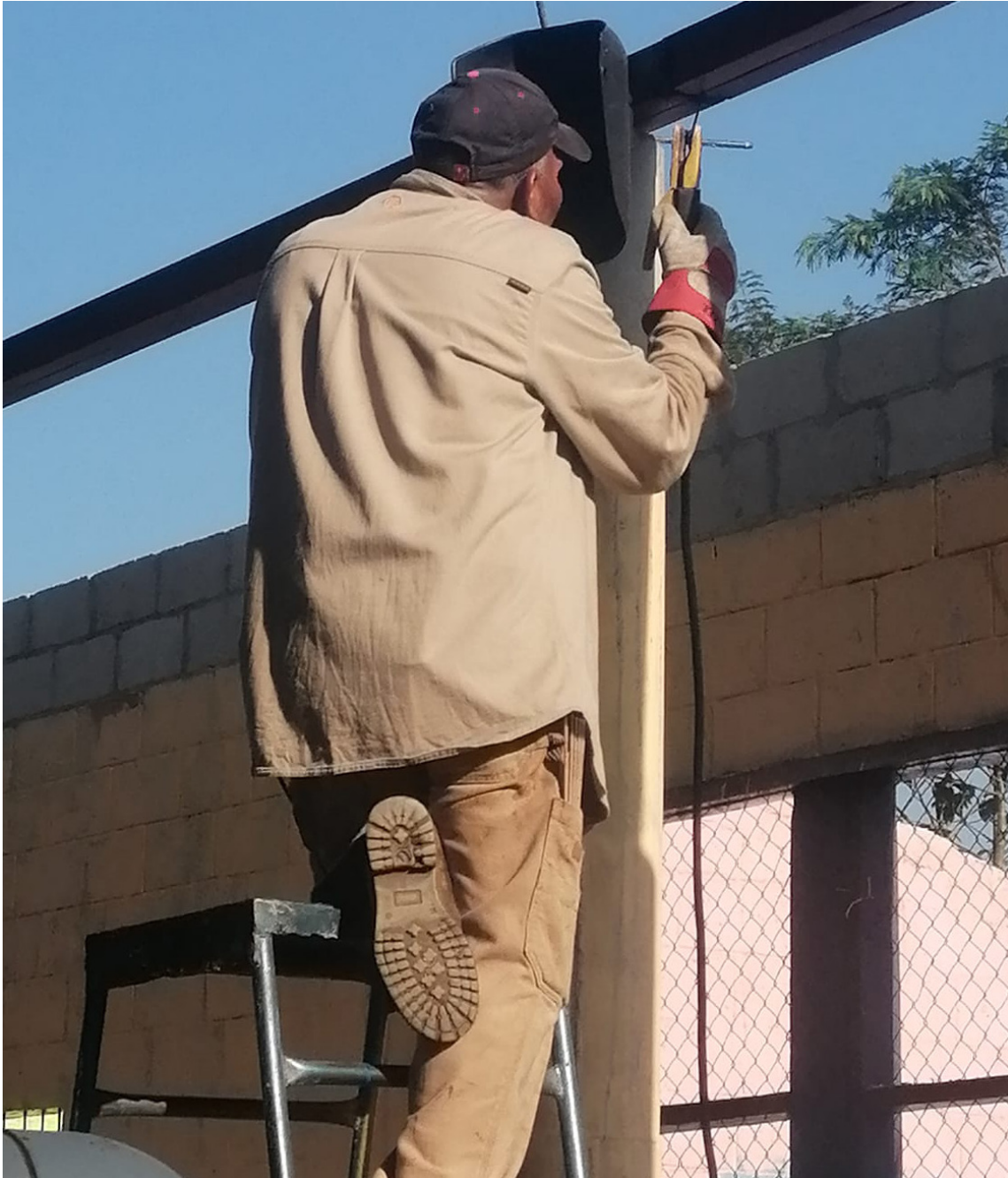
Reposición Escuela Primaria Oficial Rural Mixta zona 4, Parcelamiento Caballo Blanco, Retalhuleu, Retalhuleu.
